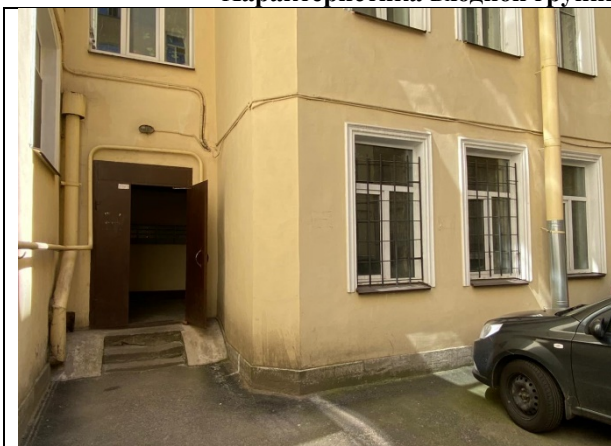
Фото 9. Общий вход со двора и окна Объекта
